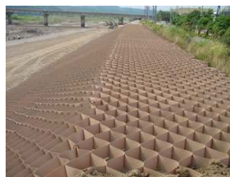
土工合成材料應用於護岸
