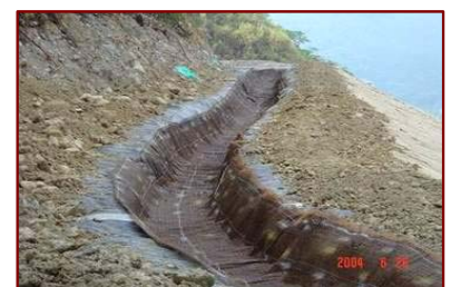
土工合成材料應用於排水設施
